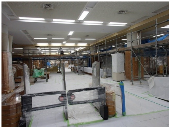
【工事中の一般閲覧室】
