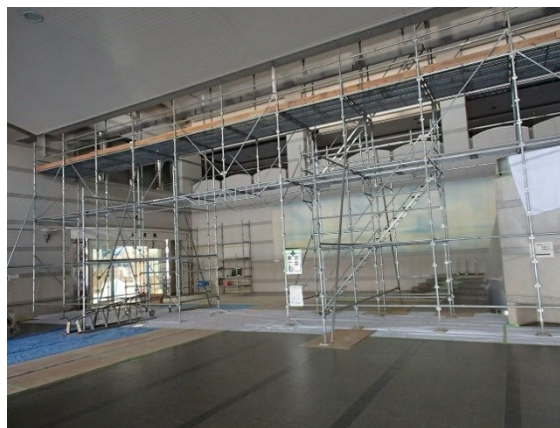
【工事中のエントランスホール】
